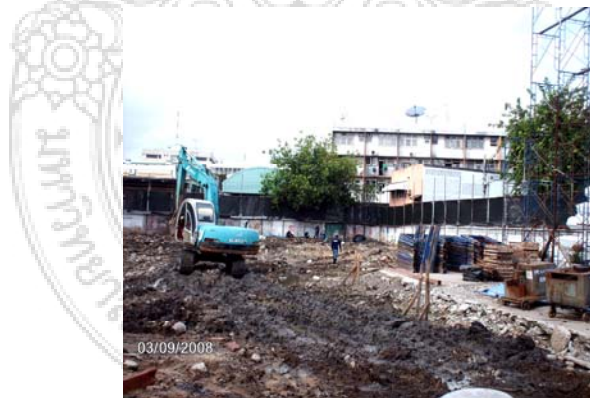
ภาพที่ 4 - 1 แสดงสถานที่ก่อสร้าง
