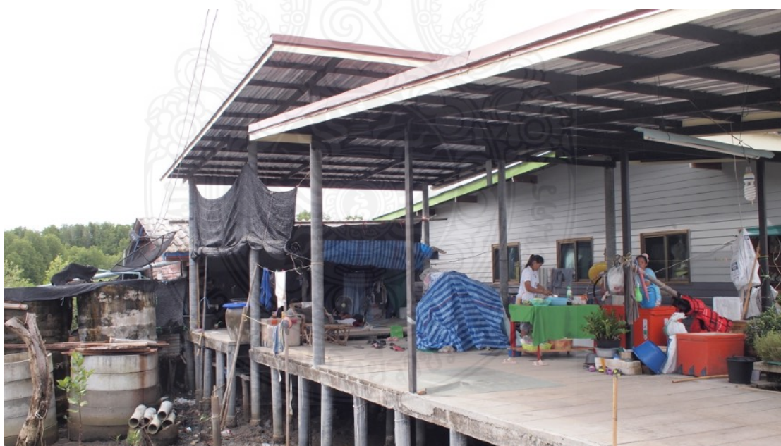
ภาพที่ 23 ภาพแสดงวัสดุและลักษณะของการก่อสร้าง (2)
