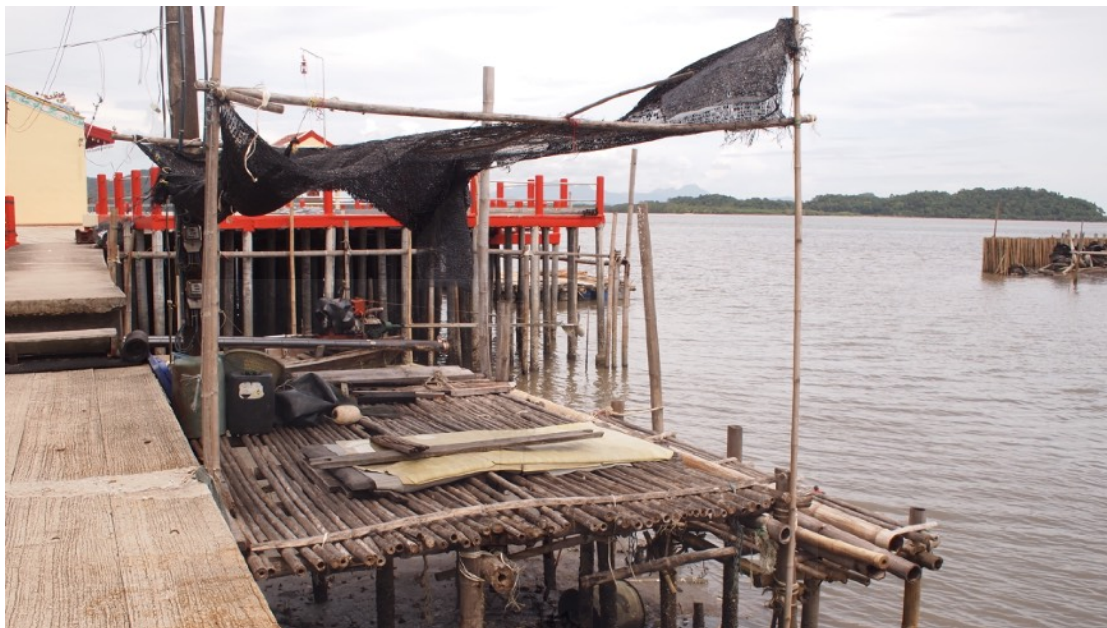
ภาพที่ 22 ภาพแสดงวัสดุและลักษณะของการก่อสร้าง (1)
