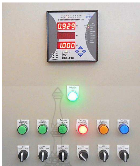
ภาพที่ 4-3 ค่า \cos\theta หลังการขนานคาปาซิเตอร์เข้าระบบ
