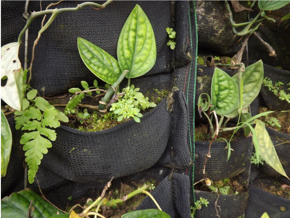
ภาพที่ 2.8 สวนแนวตั้งผนังกาแพงใช้แผ่นพินทาเป็นกระเปาะปลูกต้นไม้ที่Garden by the bayสิงคโปร์ ที่มา : นิรัตน์ พูลเกิด, (2556)
