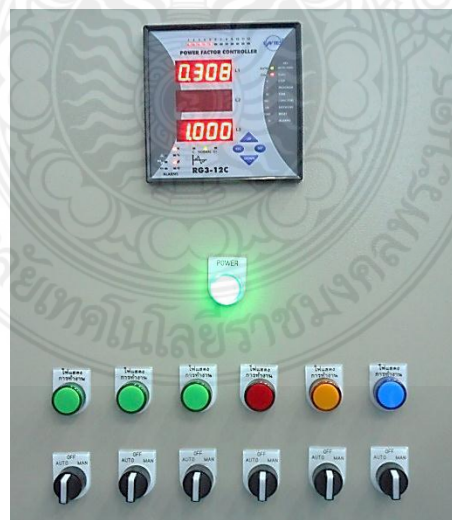
ภาพที่ 4-5 ค่า \cos\theta ก่อนการขนานคาปาซิเตอร์เข้าระบบ
