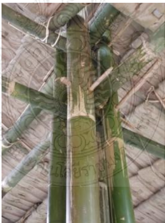
ภาพที่ 2.28 แสดงลักษณะของการผูกโครงหลังคา
