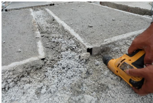
รูปที่ 3.30 การถอดแบบผนังคอนกรีตสำเร็จรูปผสมเศษโฟมจากบรรจุภัณฑ์เหลือทิ้งด้วยสว่านไฟฟ้า
