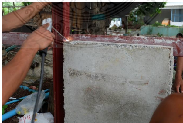
รูปที่ 4.21 การเชื่อมผนังคอนกรีตสำเร็จรูปผสมเศษโพงจากบรรจุภัณฑ์เหลือทิ้งเข้ากับเสาเหล็ก
