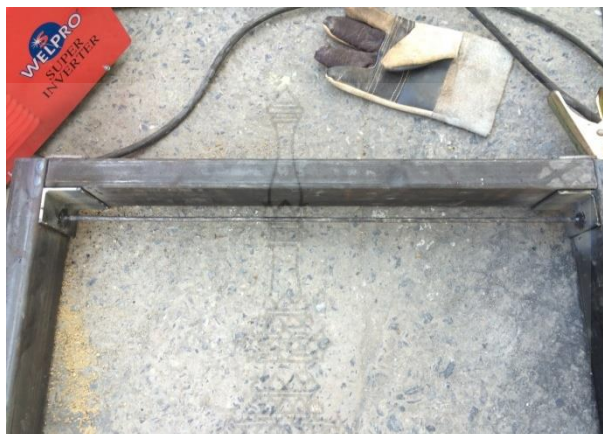
รูปที่ 3.22 การวางเหล็กฉากและเหล็กเส้นลงในแบบหล่อผนังคอนกรีต
