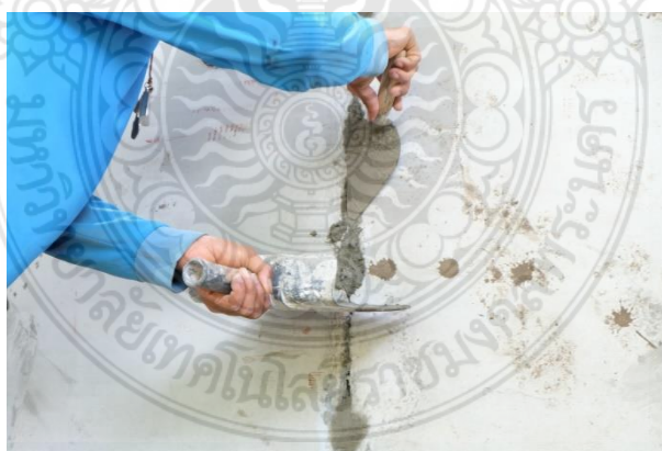
รูปที่ 4.33 ร่องของผนังคอนกรีตสำเร็จรูปผสมเศษโพลีเมอร์จากบรรจุภัณฑ์เหลือทิ้ง ที่ถูกปิดให้เรียบด้วยปูนฉาบ
