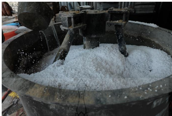
รูปที่ 3.27 การผสมคอนกรีตและเศษโฟมเหลือทิ้งจากบรรจุภัณฑ์ด้วยเครื่องผสมคอนกรีต
