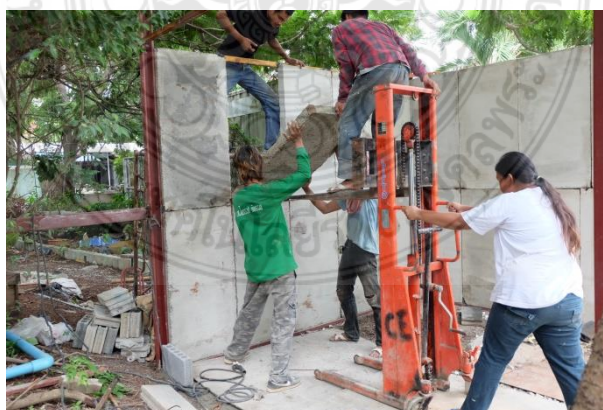
รูปที่ 4.27 การใช้อุปกรณ์ยกผนังคอนกรีตสำเร็จรูปผสมเศษโพงจากบรรจุภัณฑ์เหลือทิ้ง เพื่อติดตั้งผนังชั้นที่สอง
