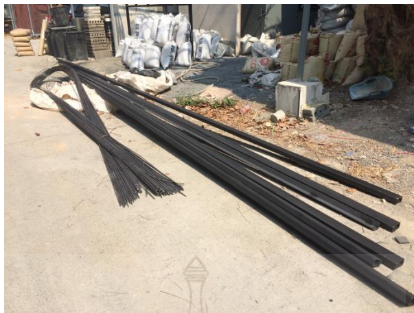
รูปที่ 3.5 เหล็กเส้นและเหล็กรูปพรรณบางส่วนที่ใช้ในโครงการ
