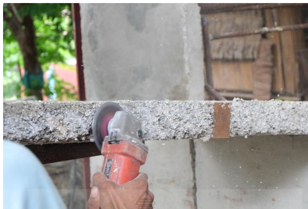
รูปที่ 4.28 การตกแต่งขอบของผนังคอนกรีตสำเร็จรูปผสมเศษโฟมจากบรรจุภัณฑ์เหลือทิ้งด้วยเครื่องตัดคอนกรีต-เหล็กแบบมือถือ
