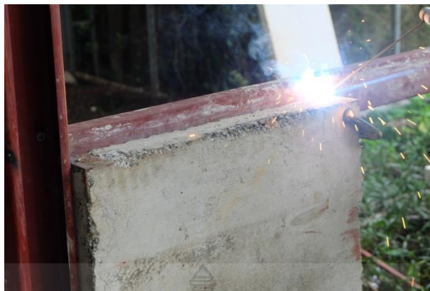
รูปที่ 4.22 การเชื่อมผนังคอนกรีตสำเร็จรูปผสมเศษโฟมจากบรรจุภัณฑ์เหลือทิ้งเข้ากับโครงรับผนังชั่วคราว
