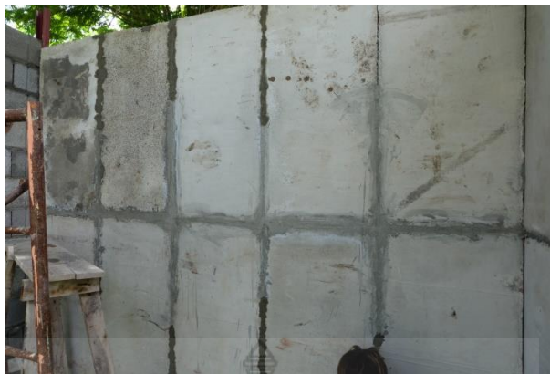
รูปที่ 4.34 ผนังคอนกรีตสำเร็จรูปผสมเศษโพลีเมอร์จากบรรจุภัณฑ์เหลือทิ้ง ที่ก่อสร้างเป็นผนังและฉาบเรียบเรียบร้อยแล้ว
