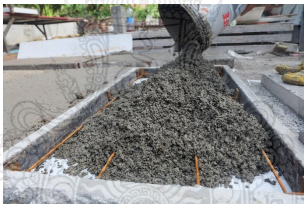
รูปที่ 3.28 การเทส่วนผสมลงในแบบหล่อผนังคอนกรีตสำเร็จรูปผสมเศษโฟมจากบรรจุภัณฑ์เหลือทิ้งที่มีการติดตั้งโครงเหล็กไว้แล้ว
