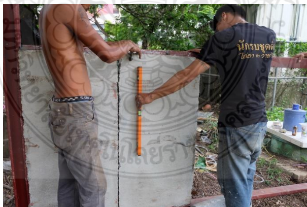
รูปที่ 4.24 การวัดระดับให้กับผนังคอนกรีตสำเร็จรูปผสมเศษโฟมจากบรรจุภัณฑ์เหลือทิ้งด้วยระดับน้ำ
