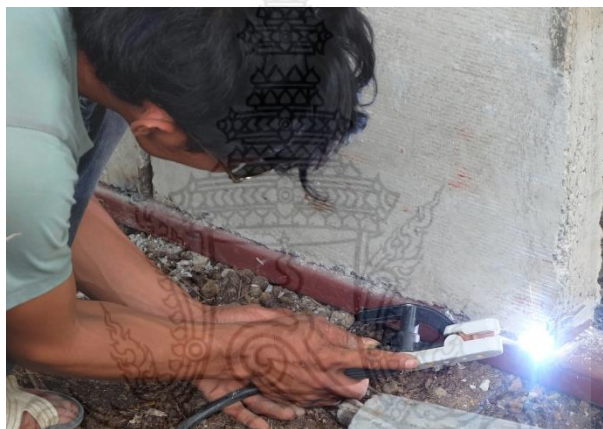
รูปที่ 4.26 การเชื่อมส่วนล่างของผนังคอนกรีตสำเร็จรูปผสมเศษโพงจากบรรจุภัณฑ์ เหลือทิ้งเข้ากับโครงเหล็ก
