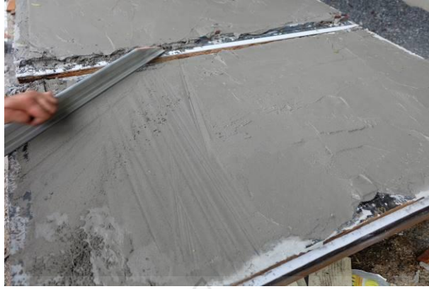
รูปที่ 5 การฉาบมอร์ตาร์ให้เรียบเพื่อใช้เป็นผนังสำเร็จรูปด้านนอกซึ่งภายในมีการติดตั้งเหล็กต่างๆ ไว้
