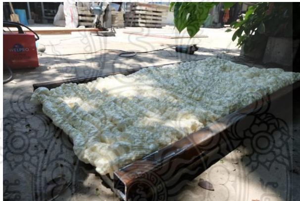
รูปที่ 6 โฟมในช่องว่างระหว่างแผ่นมอร์ตาร์ทั้งสองด้านภายหลังการขยายตัว
