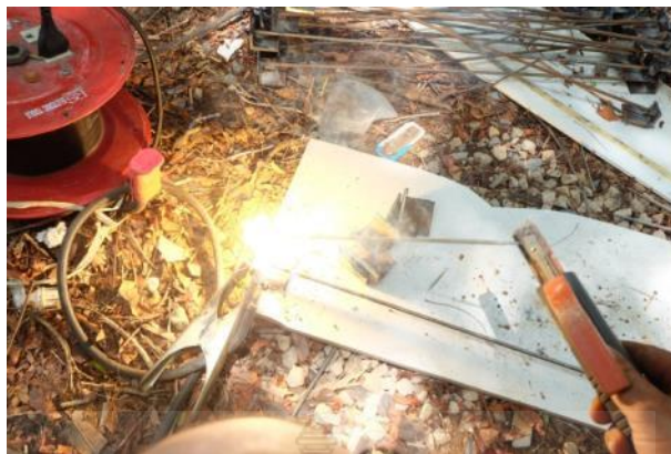
รูปที่ 3.14 การเชื่อมเหล็กแผ่นและเหล็กเส้นให้ติดกันด้วยลวดเชื่อมไฟฟ้าตามที่ได้ออกแบบ
