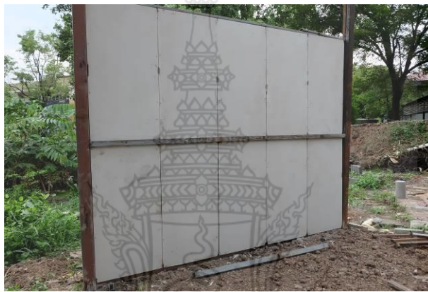
รูปที่ 22 ลักษณะผนังคอนกรีตสำเร็จรูปมวลเบาด้วยวิธีฉีดยึดโฟมเป็นแกนกลางก่อนการฉาบ
