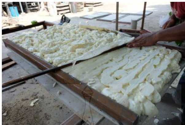
รูปที่ 3.35 การตัดโฟมที่เกินจากขอบผนังสำเร็จรูปออก
