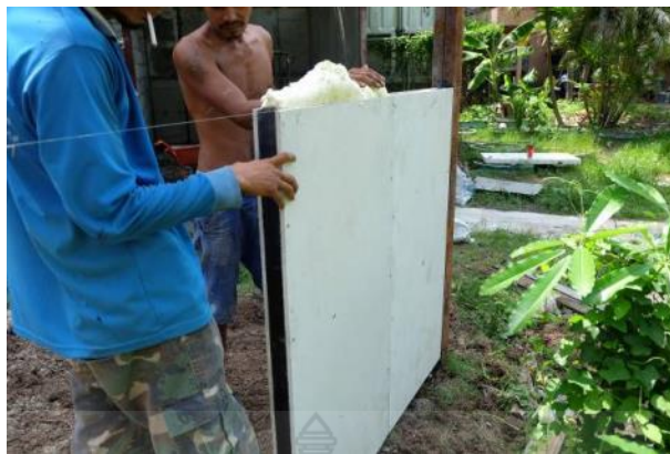
รูปที่ 4.16 การติดตั้งผนังคอนกรีตสำเร็จรูปมวลเบาด้วยวิธีฉีดโฟมเป็นแกนกลาง ตามแนวระดับที่กำหนดไว้
