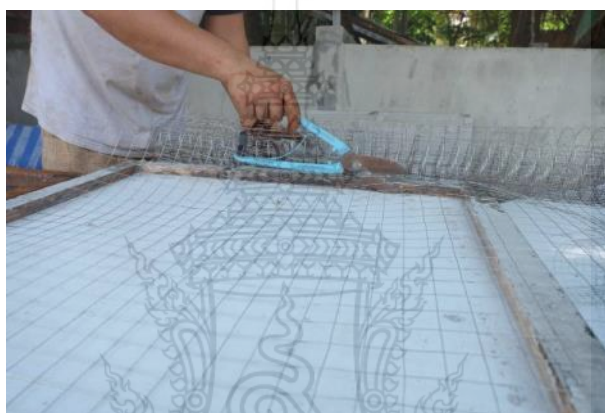
รูปที่ 3.18 เหล็กตะแกรงสำหรับเพิ่มความแข็งแรงและลดการแตกร้าวให้กับพื้นผิวผนังสำเร็จรูปด้านนอก
