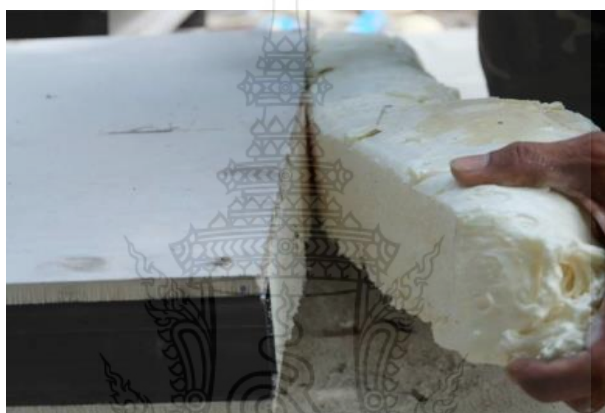
รูปที่ 3.41 การตัดโฟมส่วนเกินออกจากผนังสำเร็จรูป
