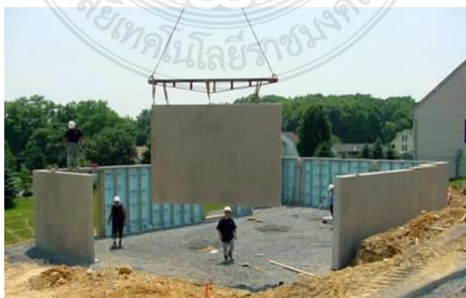
รูปที่ 1.2 การก่อสร้างโดยการใช้ชิ้นส่วนคอนกรีตสำเร็จรูป
