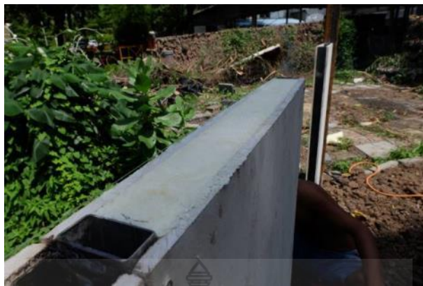
รูปที่ 4.19 ลักษณะการเชื่อมต่อกันของผนังคอนกรีตสำเร็จรูปมวลเบาด้วยวิธีฉีดยาโฟมเป็นแกนกลาง
