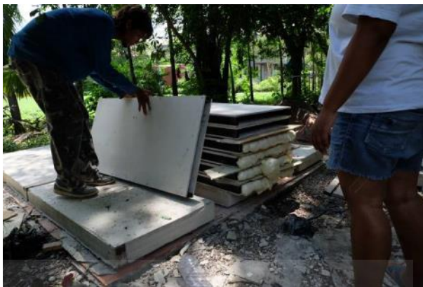
รูปที่ 3.37 การตรวจสอบความสมบูรณ์ของโฟมที่อยู่ภายในช่องว่าง
