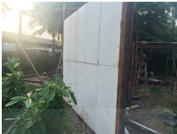
รูปที่ 4.22 ลักษณะผนังคอนกรีตสำเร็จรูปมวลเบาด้วยวิธีฉีดโฟมเป็นแกนกลางที่ก่อสร้างสมบูรณ์แล้ว
