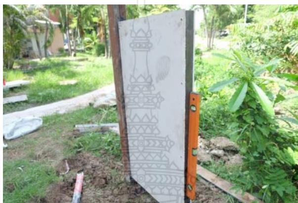
รูปที่ 4.14 การตั้งแนวผนังคอนกรีตสำเร็จรูปมวลเบาด้วยวิธีฉีดโฟมเป็นแกนกลางโดยใช้ระดับน้ำ
