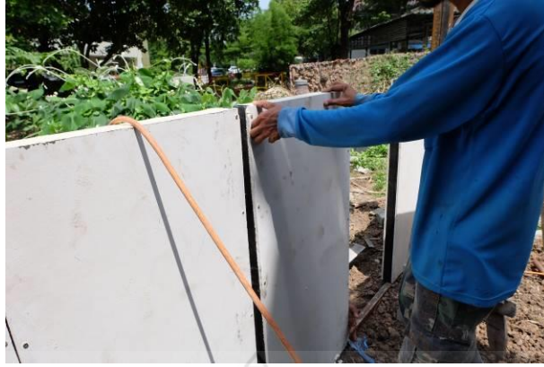
รูปที่ 21 การติดตั้งผนังคอนกรีตสำเร็จรูปมวลเบาด้วยวิธีฉีดยึดโฟมเป็นแกนกลางต่อไปจนครบ
