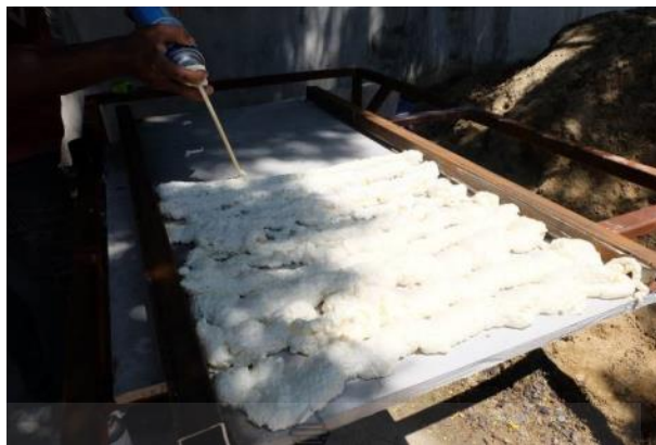
รูปที่ 3.32 การฉีดโฟมลงในช่องว่างระหว่างแผ่นมอร์ตาร์ทั้งสองด้านให้เต็มโดยการไล่ฉีดเป็นแนว
