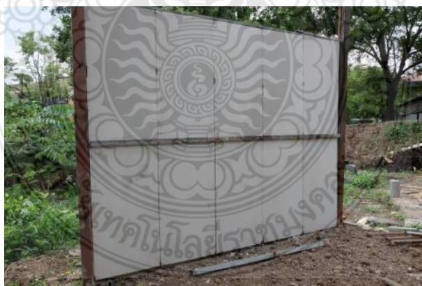
รูปที่ 4.21 ลักษณะผนังคอนกรีตสำเร็จรูปมวลเบาด้วยวิธีฉีดยาโฟมเป็นแกนกลางก่อนการฉาบ
