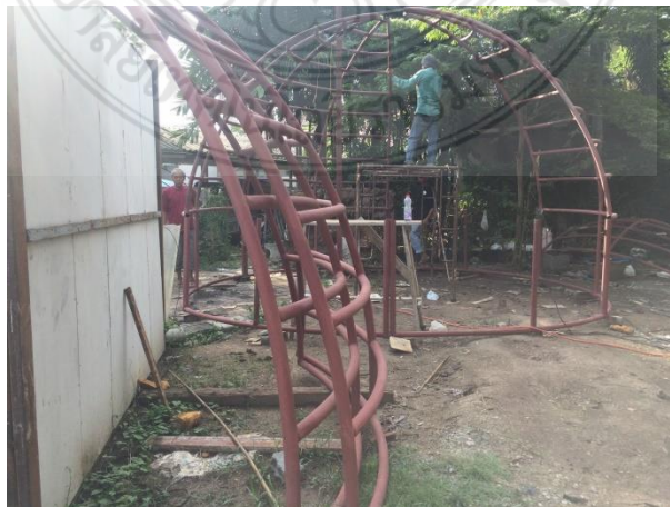
รูปที่ 13 การประกอบโครงสร้างผนังส่วนล่างเพื่อรองรับโครงสร้างผนังส่วนบน
