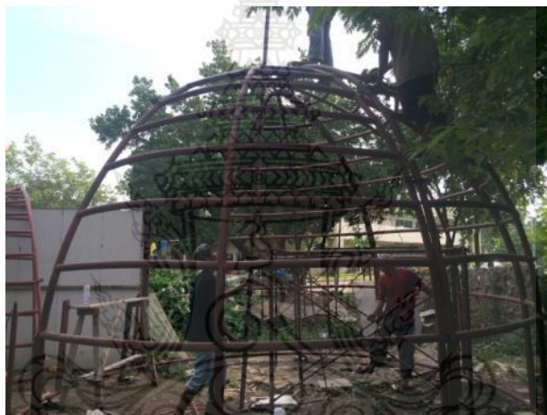
รูปที่ 4.32 การวางแนวตั้งเพื่อให้โครงสร้างผนังมีความสมมาตร
