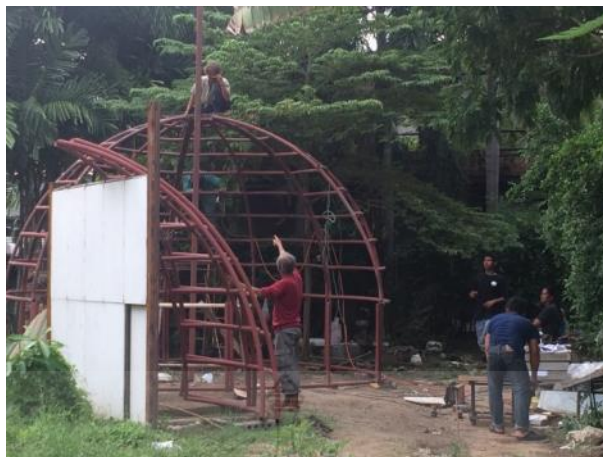
รูปที่ 4.34 โครงสร้างผนังส่วนบนและส่วนล่างที่เชื่อมติดกันแล้ว
