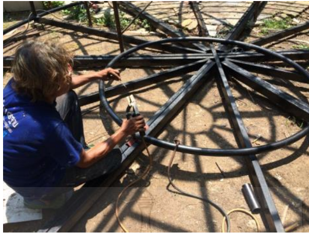
รูปที่ 4.39 การประกอบโครงสร้างหลังคาโดยการเชื่อมด้วยลวดเชื่อมไฟฟ้า
