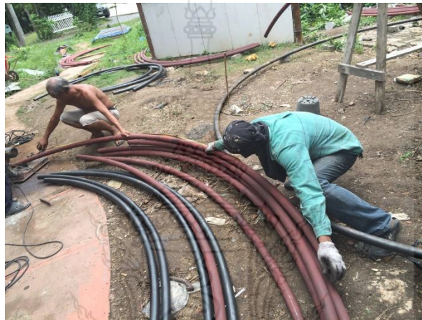
รูปที่ 9 การตัดโค้งของเหล็กรูปพรรณหน้าตัดวงกลมให้มีรัศมีต่างๆ ตามต้องการ
