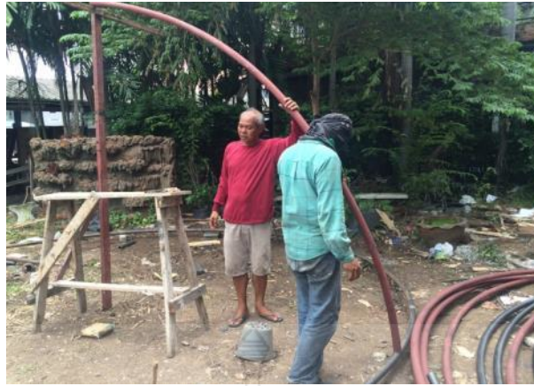
รูปที่ 4.10 การวางโครงสร้างแนวนอนและแนวตั้งของอาคารสำเร็จรูปทรงครึ่งทรงกลม
