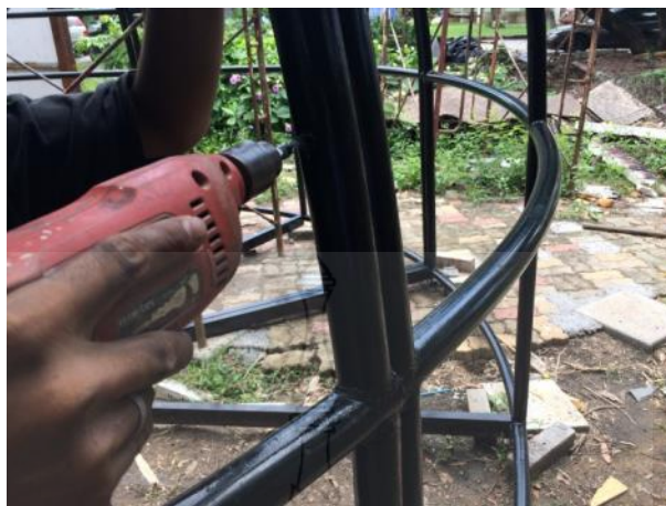
รูปที่ 4.37 การเจาะรูโครงสร้างผนังอาคารเพื่อร้อยด้วยสลักเกลียว
