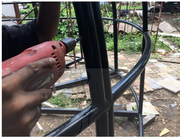
รูปที่ 17 การเจาะรูโครงสร้างผนังอาคารเพื่อร้อยด้วยสลักเกลียว
