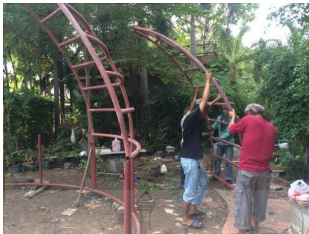
รูปที่ 4.25 การยกโครงสร้างผนังส่วนบนไปติดตั้งบนโครงสร้างผนังส่วนล่าง
