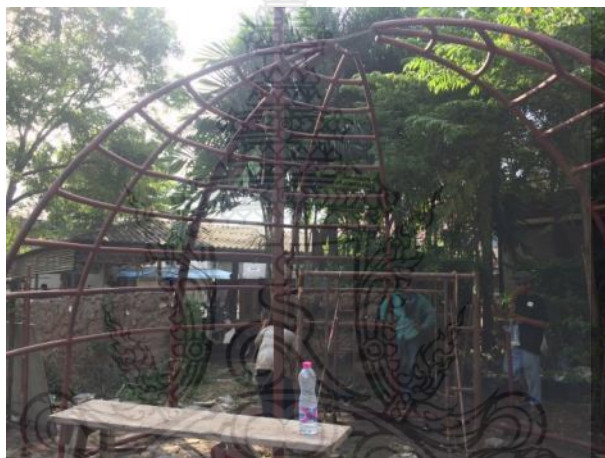
รูปที่ 4.23 การนำโครงสร้างผนังส่วนบนขึ้นไปเพื่อประกอบโครงสร้างผนังส่วนล่าง
