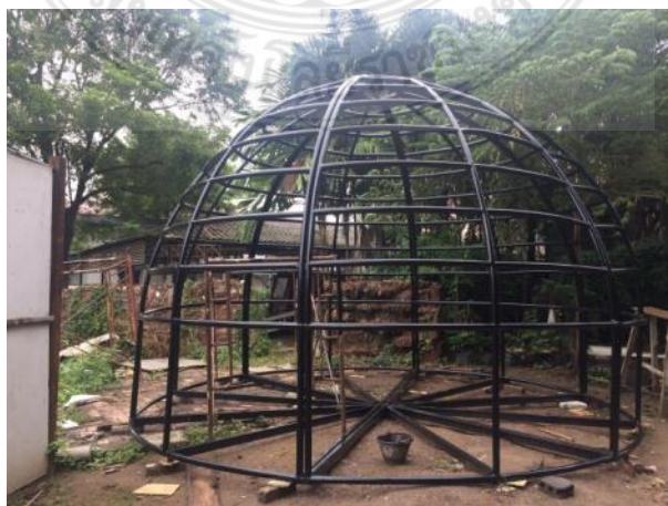
รูปที่ 4.36 โครงสร้างอาคารสำเร็จรูปทรงครึ่งทรงกลมก่อนการเจาะรูเพื่อทำรอยต่อ
