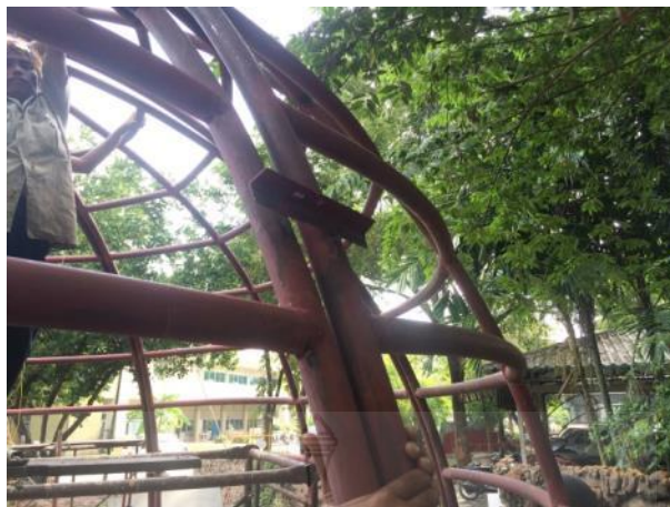
รูปที่ 4.28 การทำสลักชั่วคราวเพื่อช่วยให้โครงสร้างผนังเข้ารูปได้ง่าย
