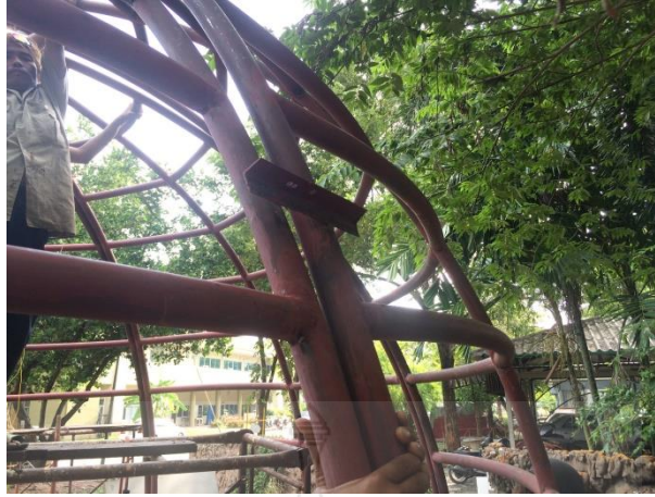
รูปที่ 14 การทำสลักชั่วคราวเพื่อช่วยให้โครงสร้างผนังเข้ารูปได้ง่าย
