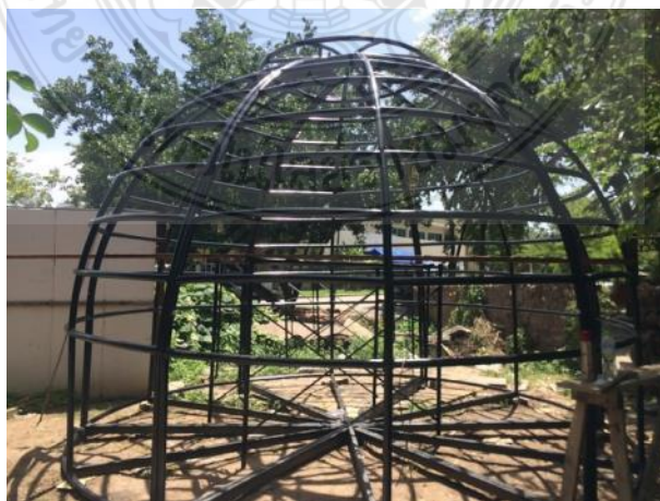
รูปที่ 4.41 โครงสร้างอาคารสำเร็จรูปทรงครึ่งทรงกลมที่มีความสมบูรณ์
