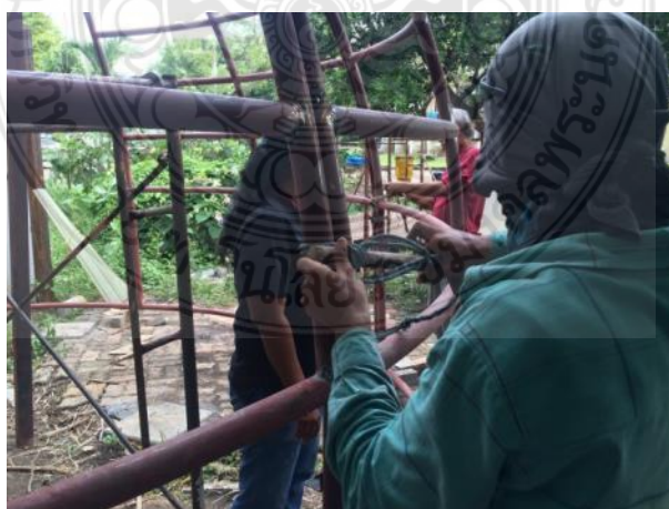
รูปที่ 4.30 การขันชะเนาะเพื่อให้โครงสร้างผนังเข้ารูปได้อย่างสมบูรณ์
