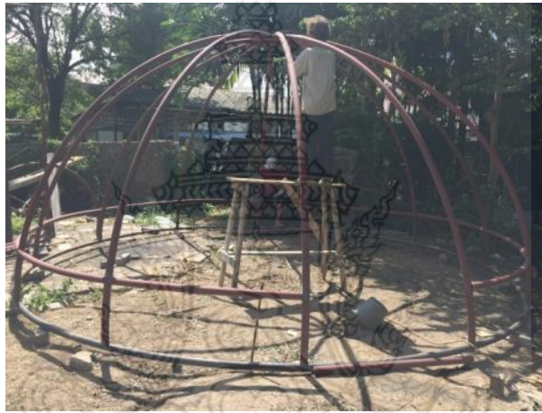
รูปที่ 4.11 โครงสร้างผนังส่วนบนของอาคารสำเร็จรูปทรงครึ่งทรงกลม
