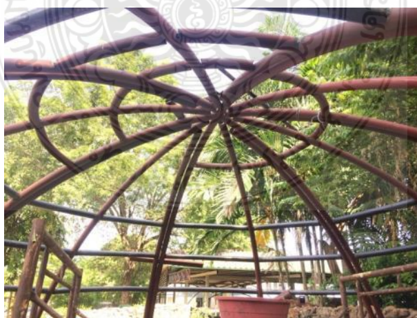
รูปที่ 4.15 ลักษณะโครงสร้างผนังแนวอนส่วนบนสุดของอาคารสำเร็จรูปทรงครึ่งทรงกลม
