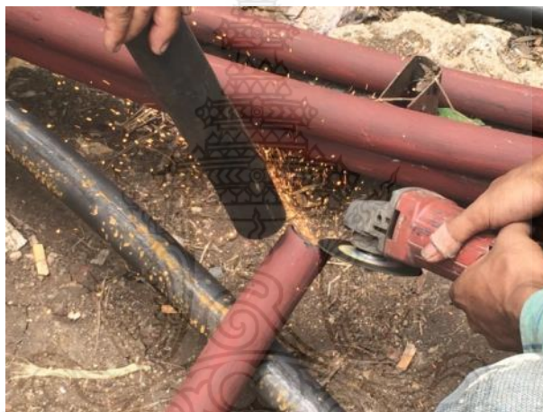
รูปที่ 4.8 การตกแต่งรอยตัดด้วยเครื่องเจียรแบบมือถือ
