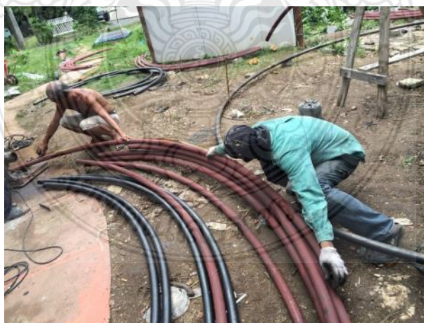
รูปที่ 4.6 การตัดโค้งของเหล็กรูปพรรณหน้าตัดวงกลมให้มีรัศมีต่างๆ ตามต้องการ
