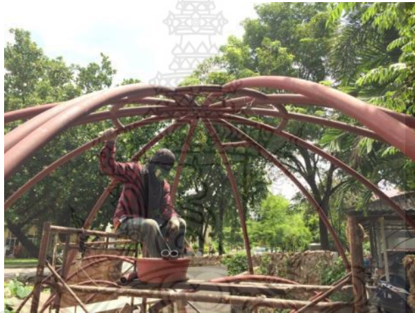
รูปที่ 4.14 การติดตั้งโครงสร้างผนังแนวอนส่วนบนสุดของอาคารสำเร็จรูปทรงครึ่งทรงกลม
