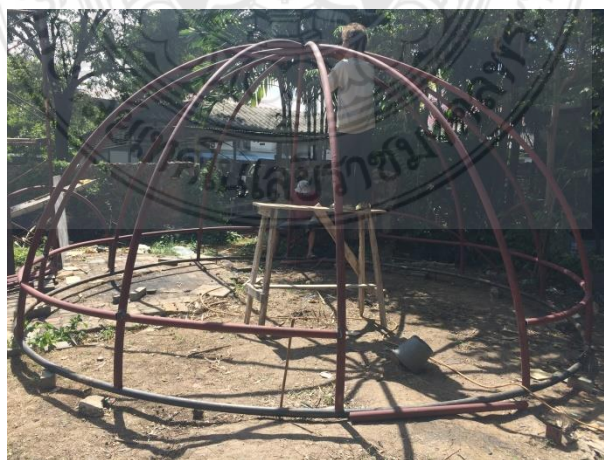
รูปที่ 10 โครงสร้างผนังส่วนบนของอาคารสำเร็จรูปทรงครึ่งทรงกลม
