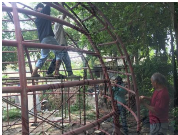
รูปที่ 4.26 การนำโครงสร้างผนังส่วนบนวางบนโครงสร้างผนังส่วนล่าง
