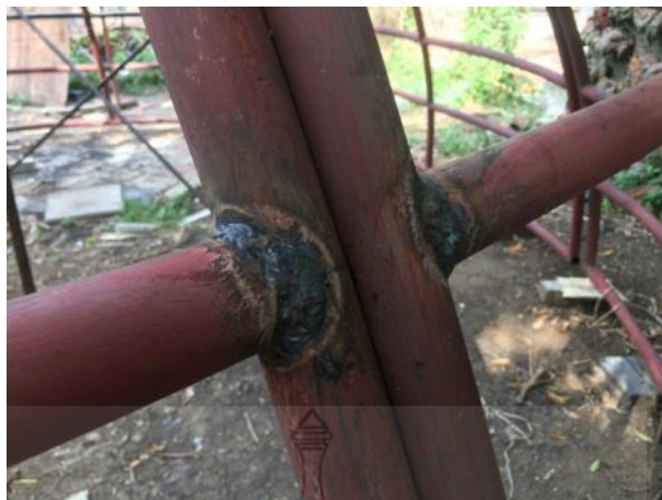
รูปที่ 4.16 การเชื่อมพอกบริเวณรอยต่อของอาคารสำเร็จรูปทรงครึ่งทรงกลม
