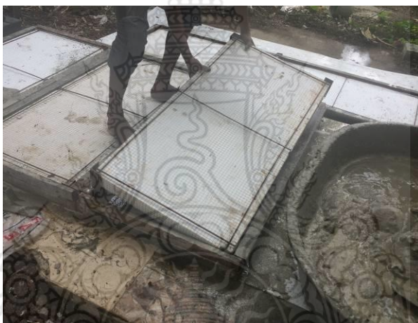
รูปที่ 3.26 การวางแผ่นโคมอัดแน่นลงบนมอร์ตาร์สำหรับขึ้นรูปผนังคอนกรีตสำเร็จรูป
