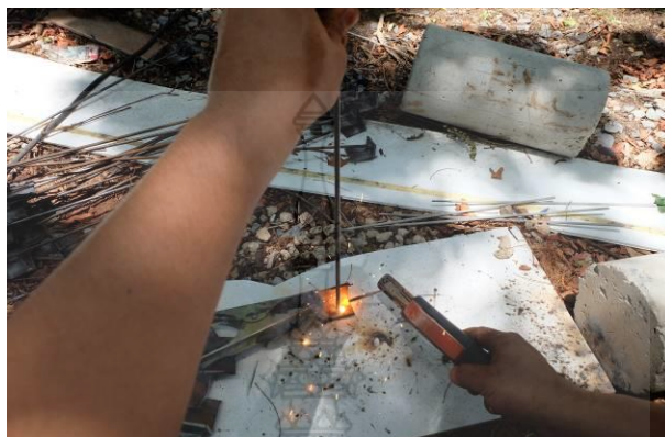
รูปที่ 3.19 การเชื่อมเหล็กฉากและเหล็กแผ่นเข้ากับเหล็กเส้นด้วยลวดเชื่อมไฟฟ้า
