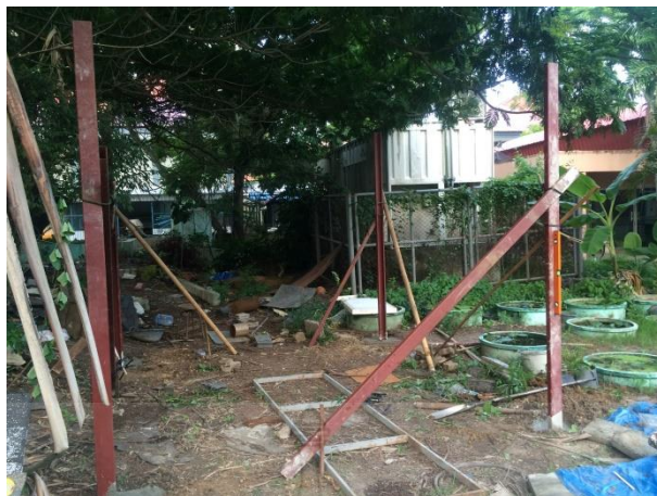
รูปที่ 4.16 การตั้งเสาเหล็กเพื่อติดตั้งผนังคอนกรีตสำเร็จรูปมวลเบาเสริมแผ่นโฟมอัดแน่น
