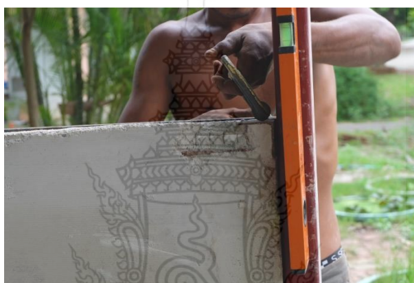
รูปที่ 4.20 การตรวจสอบแนวของผนังคอนกรีตสำเร็จรูปมวลเบาเสริมแผ่นโฟมอัดแน่นด้วยระดับน้ำ
