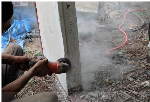
รูปที่ 4.22 การตัดแต่งผิวของผนังคอนกรีตสำเร็จรูปมวลเบาเสริมแผ่นโฟมอัดแน่น
