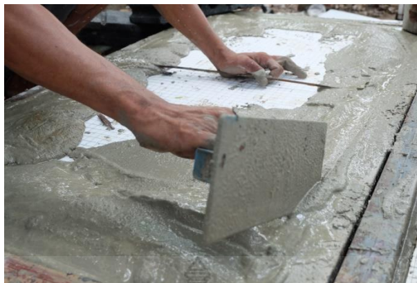
รูปที่ 3.31 การเกลี่ยมอร์ตาร์ให้ลงในขอบของแบบหล่อผนังคอนกรีตสำเร็จรูปมวลเบา เสริมแผ่นโฟมอัดแน่น
