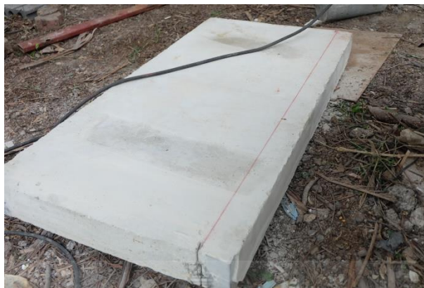
รูปที่ 4.28 การวางแผนการตัดแผ่นผนังคอนกรีตสำเร็จรูปมวลเบาเสริมแผ่นโฟมอัดแน่นให้เล็กลง
