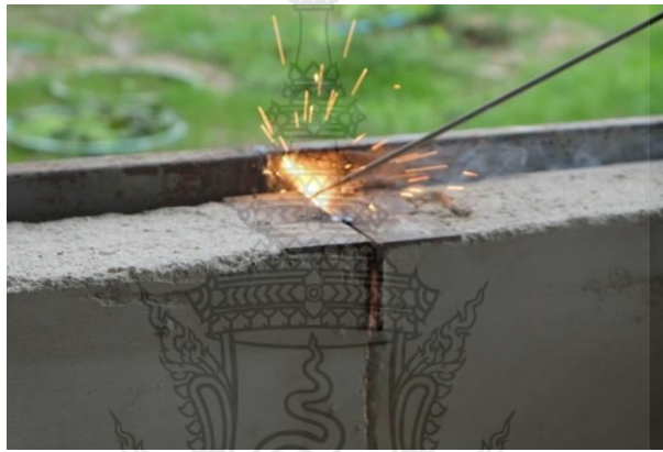
รูปที่ 18 การเชื่อมผนังคอนกรีตสำเร็จรูปมวลเบาเสริมแผ่นโฟมอัดแน่นทั้งสองแผ่นให้ยึดติดกัน
