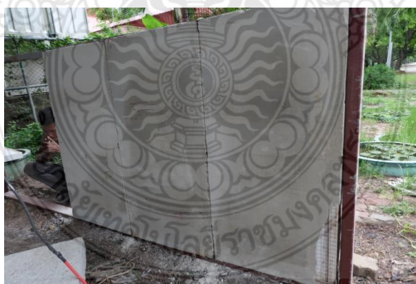
รูปที่ 4.27 ผนังคอนกรีตสำเร็จรูปมวลเบาเสริมแผ่นโฟมอัดแน่นที่ถูกเชื่อมติดกัน
