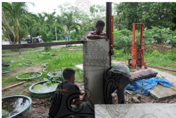
รูปที่ 4.17 การเรียงผนังคอนกรีตสำเร็จรูปมวลเบาเสริมแผ่นโฟมอัดแน่นเข้ากับเสาเหล็ก
