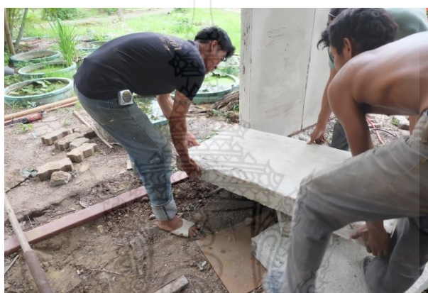
รูปที่ 4.26 การยกแผ่นผนังคอนกรีตสำเร็จรูปมวลเบาเสริมแผ่นโฟมอัดแน่นมาติดตั้งต่อไป
