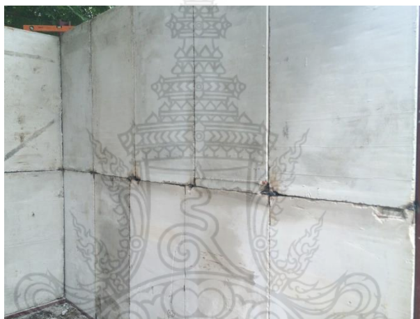
รูปที่ 4.32 ผนังคอนกรีตสำเร็จรูปมวลเบาเสริมแผ่นโฟมอัดแน่นก่อนการฉาบร่อง
