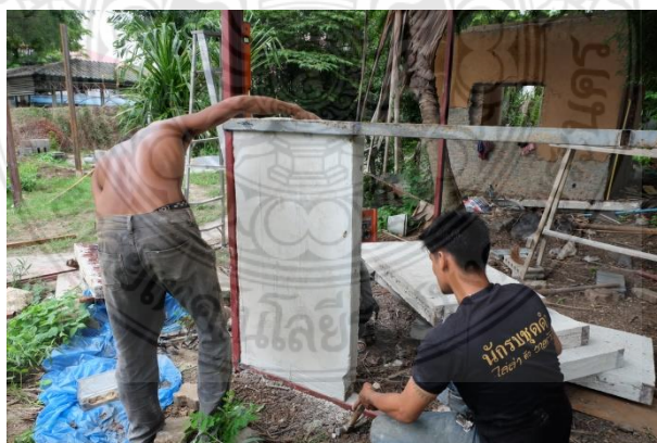
รูปที่ 4.18 การจัดผนังคอนกรีตสำเร็จรูปมวลเบาเสริมแผ่นโฟมอัดแน่นให้ได้ระดับ
