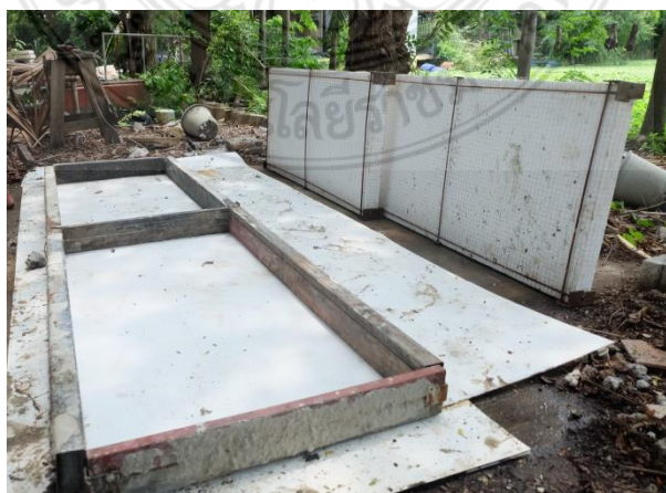
รูปที่ 3.24 การเตรียมแบบหล่อผนังคอนกรีตสำเร็จรูปมวลเบาเสริมแผ่นโฟมอัดแน่น
