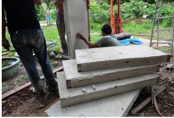
รูปที่ 17 การจัดผนังคอนกรีตสำเร็จรูปมวลเบาเสริมแผ่นโฟมอัดแน่นให้เข้ามุม
