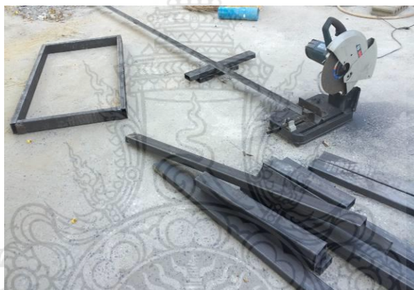
รูปที่ 3.8 การเตรียมแบบหล่อผนังคอนกรีตสำเร็จรูป
