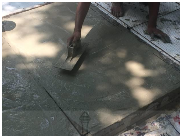
รูปที่ 3.34 การฉาบผนังคอนกรีตสำเร็จรูปมวลเบาเสริมแผ่นโฟมอัดแน่นเบื้องต้น
