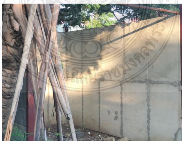
รูปที่ 4.33 ผนังคอนกรีตสำเร็จรูปมวลเบาเสริมแผ่นโฟมอัดแน่นหลังจากการฉาบร่อง
