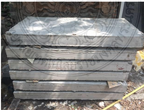
รูปที่ 6 การกองรวมผนังคอนกรีตสำเร็จรูปมวลเบาเสริมแผ่นโฟมอัดแน่นเพื่อบ่มในอากาศ
