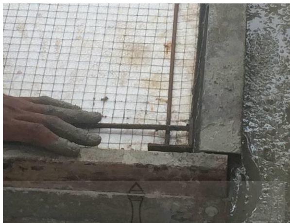
รูปที่ 3.28 ระดับของแผ่นโฟมอัดแน่นตามแนวของแบบหล่อผนังคอนกรีตสำเร็จรูป
