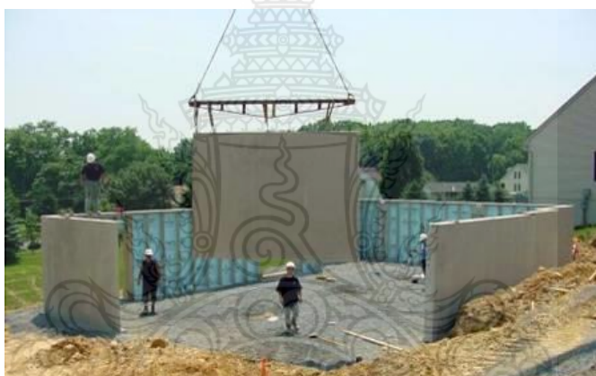
รูปที่ 1.3 การก่อสร้างโดยการใช้ชิ้นส่วนคอนกรีตสำเร็จรูป
