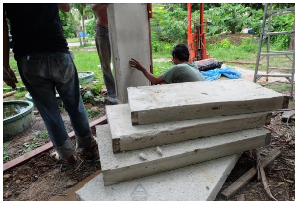
รูปที่ 4.19 การจัดผนังคอนกรีตสำเร็จรูปมวลเบาเสริมแผ่นโฟมอัดแน่นให้เข้ามุม
