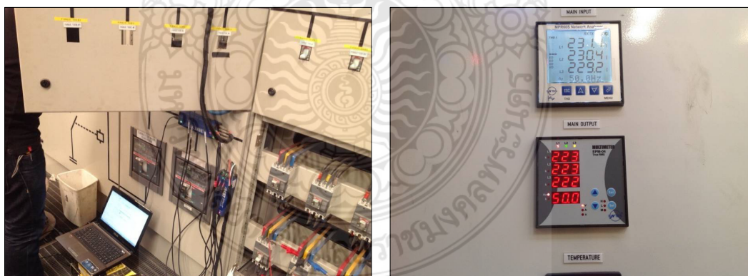
ภาพที่ 4.4 การตรวจวัดปริมาณการบริโภคพลังงานหลังการปรับปรุงของโรงงานพลาสติกไฮเทค
