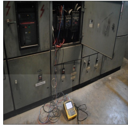
ภาพที่ 4.7 ตรวจสอบวัดพลังงานก่อนการติดตั้งอุปกรณ์โวลต์เตจเรกกูเลเตอร์โรงงานพลาสติกไทย
