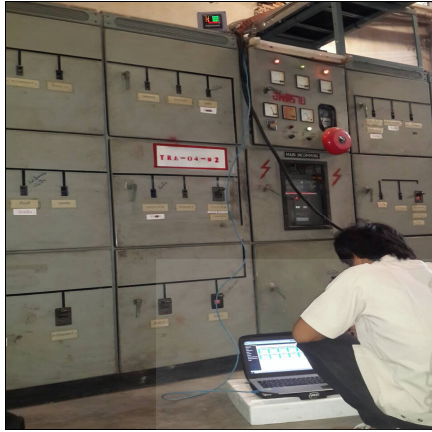
ภาพที่ 4.7 ตรวจสอบวัดพลังงานก่อนการติดตั้งอุปกรณ์โวลต์เตจเรกกูเลเตอร์โรงงานพลาสติกไทย
