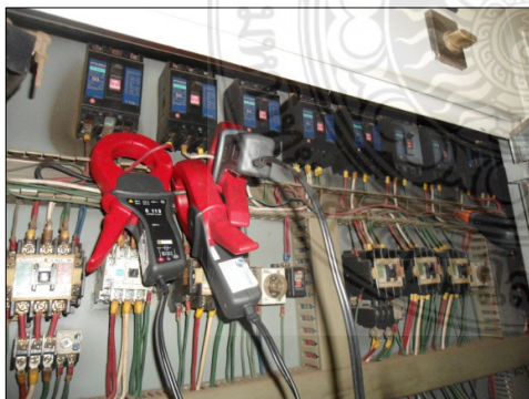
ภาพที่ 4.9 การตรวจวัดปริมาณการบริโภคพลังงานหลังการปรับปรุงของโรงงานพลาสติกไทย
