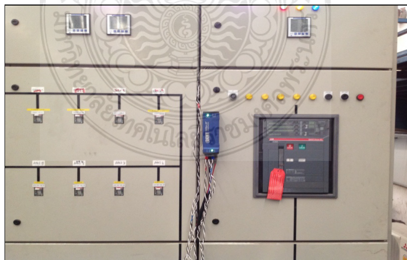
ภาพที่ 4.2 การตรวจวัดปริมาณการบริโภคพลังงานก่อนการปรับปรุงของโรงงานพลาสติกไฮเทค
