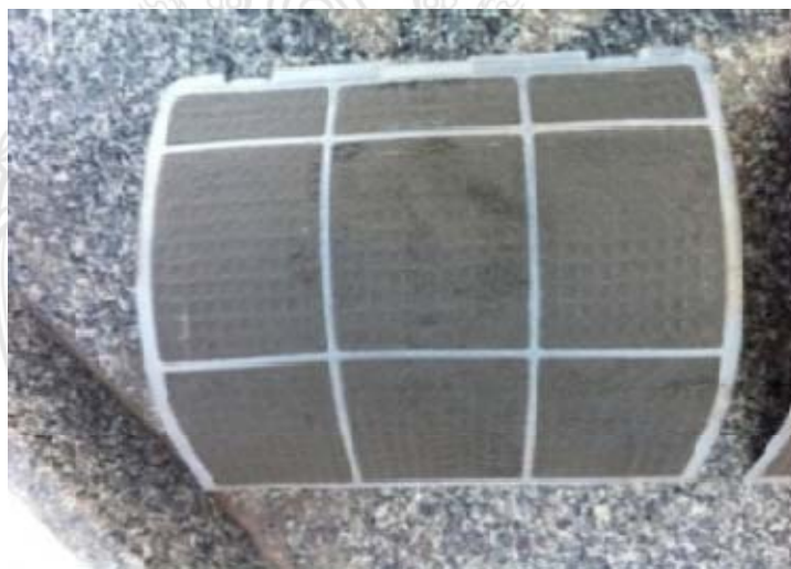
ภาพ 3.12 ล้างทำความสะอาดกรองอากาศ
