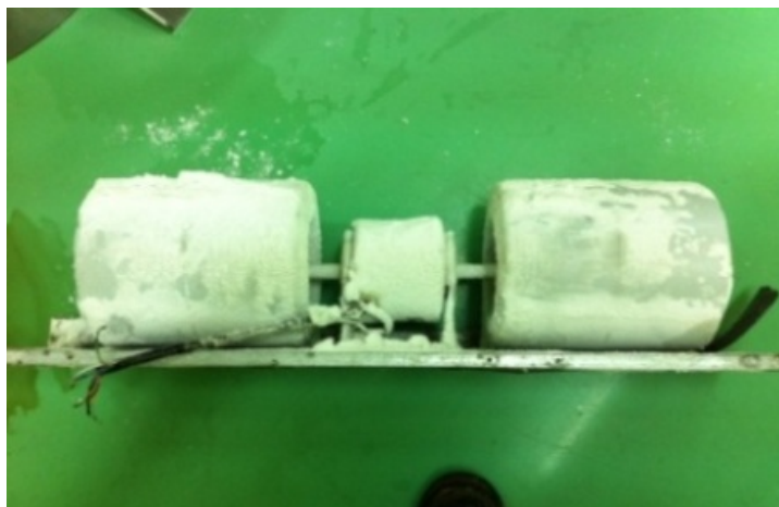
ภาพ 3.11 ล้างทำความสะอาดพัดลมคอยล์เย็น
