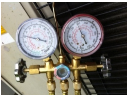
ภาพ 3.3 วัดค่าแรงดันของระบบสารทำความเย็นก่อนการบำรุงรักษา
