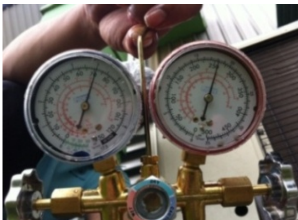
ภาพ 3.13 วัดค่าแรงดันของระบบสารทำความเย็นหลังการบำรุงรักษา
