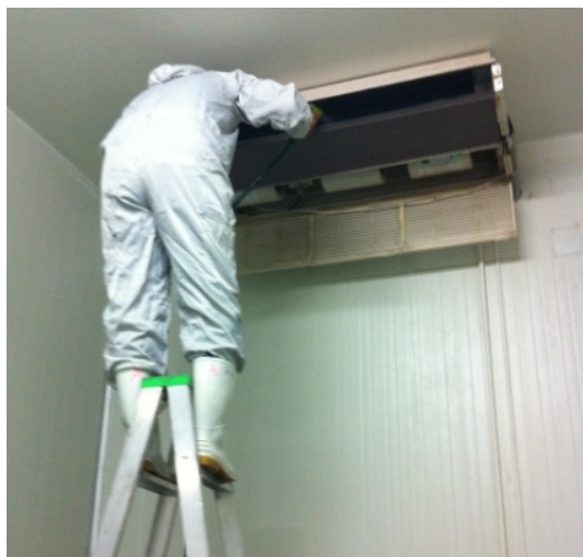
ภาพ 3.9 ล้างทำความสะอาดอีแวปอเรเตอร์
