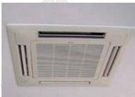
ภาพ 2.10 เครื่องปรับอากาศแบบแยกส่วนชนิดติดตั้งเพดาน (Ceiling type)
