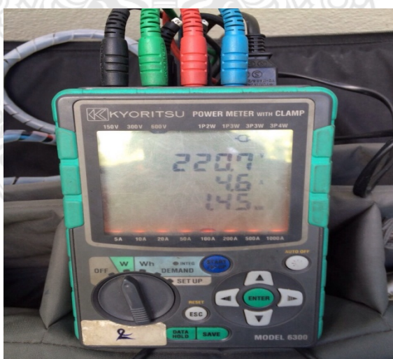
ภาพ 3.14 วัดค่าแรงดันไฟฟ้า กระแสไฟฟ้าและกำลังไฟฟ้าของเครื่องปรับอากาศหลังการบำรุงรักษา
