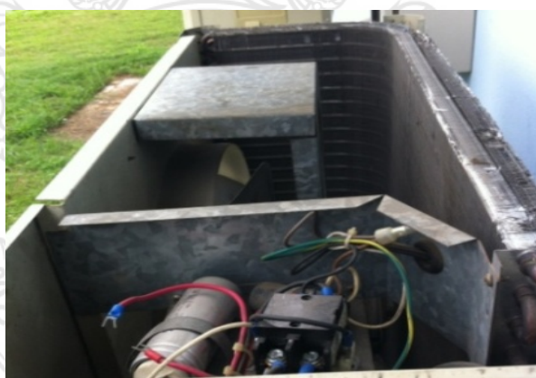
ภาพ 3.10 ล้างทำความสะอาดคอนเดนเซอร์
