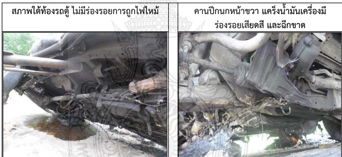
รูปที่ 4.2-14 ภาพถ่ายใต้ท้องรถดู คานปีกนกหน้าขวา และเครื่องน้ำมันเครื่อง
