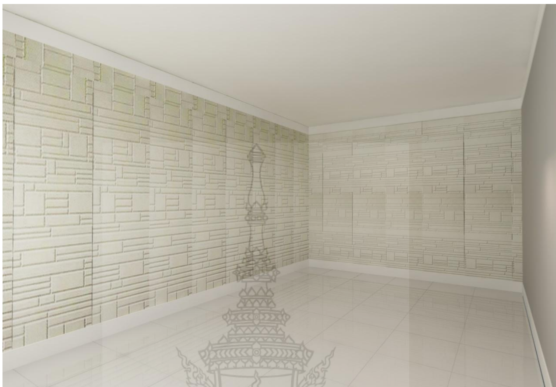
ภาพ ก 9 การติดตั้งแผ่นฉนวนกันความร้อน ขนาด 0.60x0.60 ม. วางลายต่อเนื่อง
