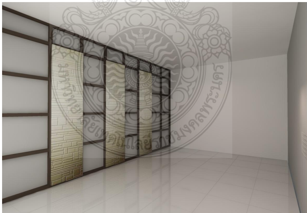
ภาพ ก 8 การติดตั้งแผ่นฉนวนกันความร้อน ขนาด 0.60x0.60 ม. วางลายต่อเนื่อง
