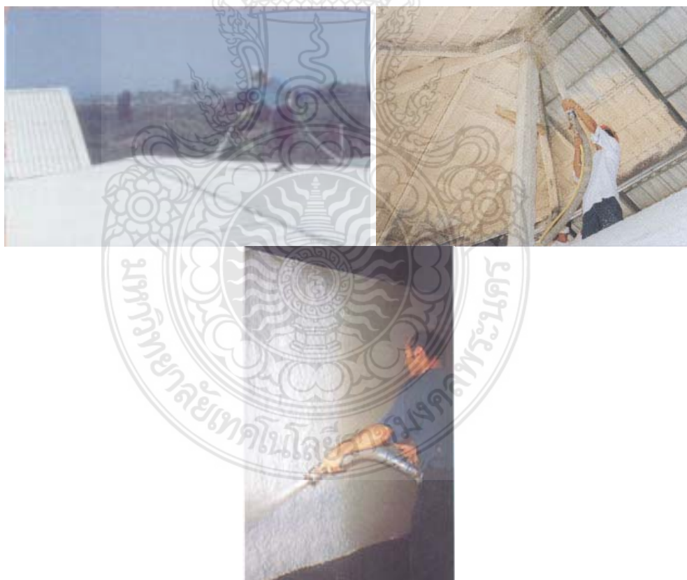
ภาพที่ 2.27 แสดงการใช้งานฉนวนบริเวณหลังคา และผนัง
