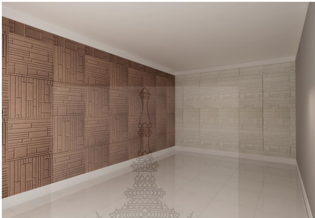
ภาพ ก 7 การติดตั้งแผ่นฉนวนกันความร้อน ขนาด 0.60x0.60 ม. วางสลับกับ
