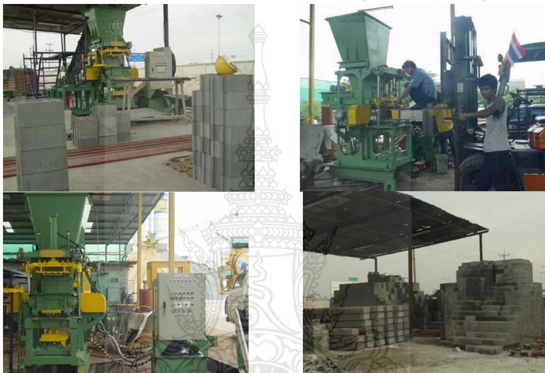
ภาพที่ 2.7 กระบวนการผลิตคอนกรีตบล็อก
