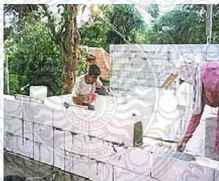
ภาพที่ 2.10 การก่อผนังคอนกรีตบล็อกมวลเบา
