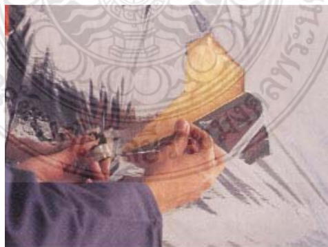
ภาพที่ 2.25 แสดงการซ่อมแซมฉนวนใยแก้วที่มีการฉีกขาดต้องใช้เทปใสหรือฟอยล์ปิดให้สนิท เพื่อป้องกันความชื้นซึมเข้าเนื้อใยแก้ว ที่มา : http://www.spec2u.com/product/microfiber/index.asp
