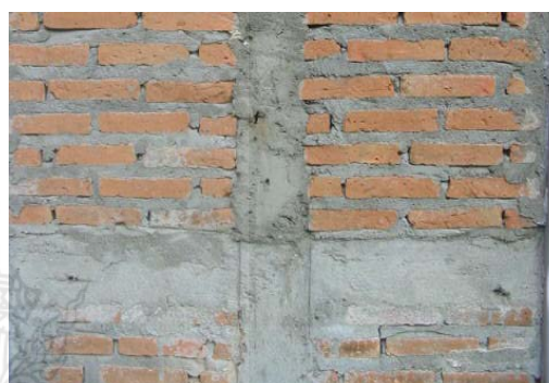
ภาพที่ 2.2 แสดงลักษณะทั่วไปของอิฐมอญ อิฐกลวง และการก่อผนังอิฐ
