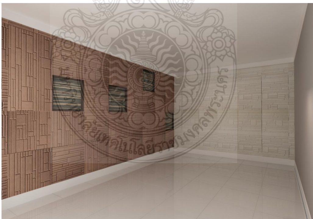
ภาพ ก 6 การติดตั้งแผ่นฉนวนกันความร้อน ขนาด 0.60x1.20 ม. วางสลับกับ
