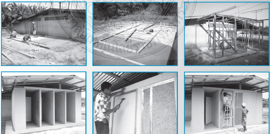
ภาพที่ 2.60 ภาพการก่อสร้างห้องทดลองและติดตั้งแผ่นฉนวน
