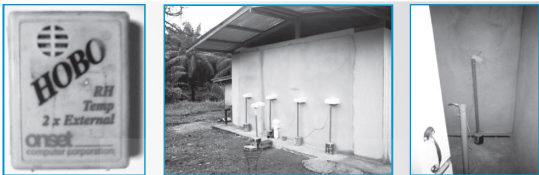
ภาพที่ 2.61 ภาพเครื่องมือวัดอุณหภูมิ และการติดตั้งภายนอก - ภายในอาคาร
