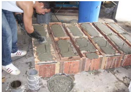
รูปที่ 3-2 การหล่อแท่งคอนกรีตเพื่อทดสอบ
