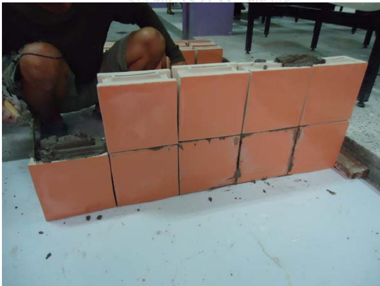
ภาพที่ 11 ก่อผนังชั้นที่ 2 ตามแนวยาว 1 เมตร
