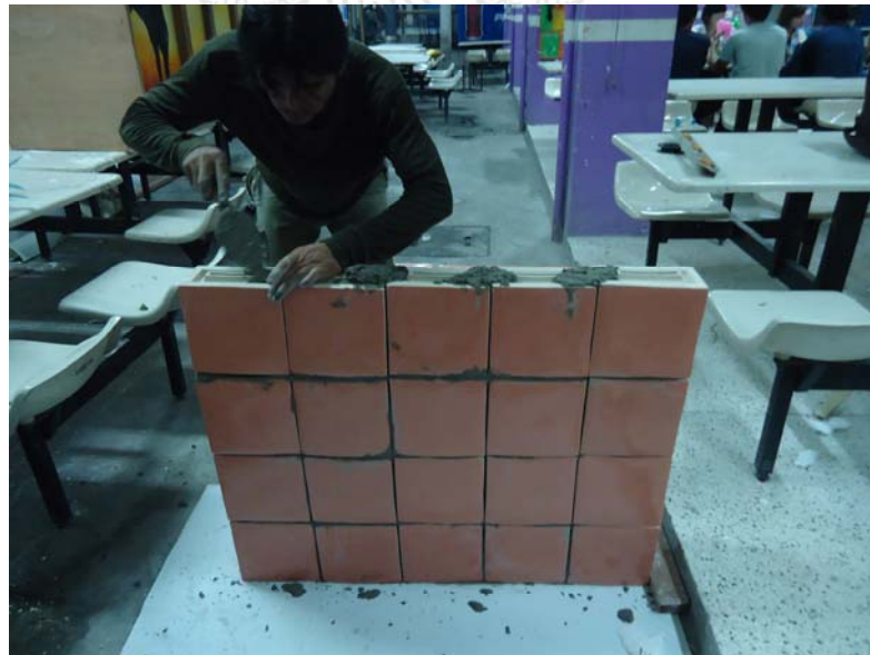
ภาพที่ 13 ก่อผนังชั้นที่ 4 ตามแนวยาว 1 เมตร
